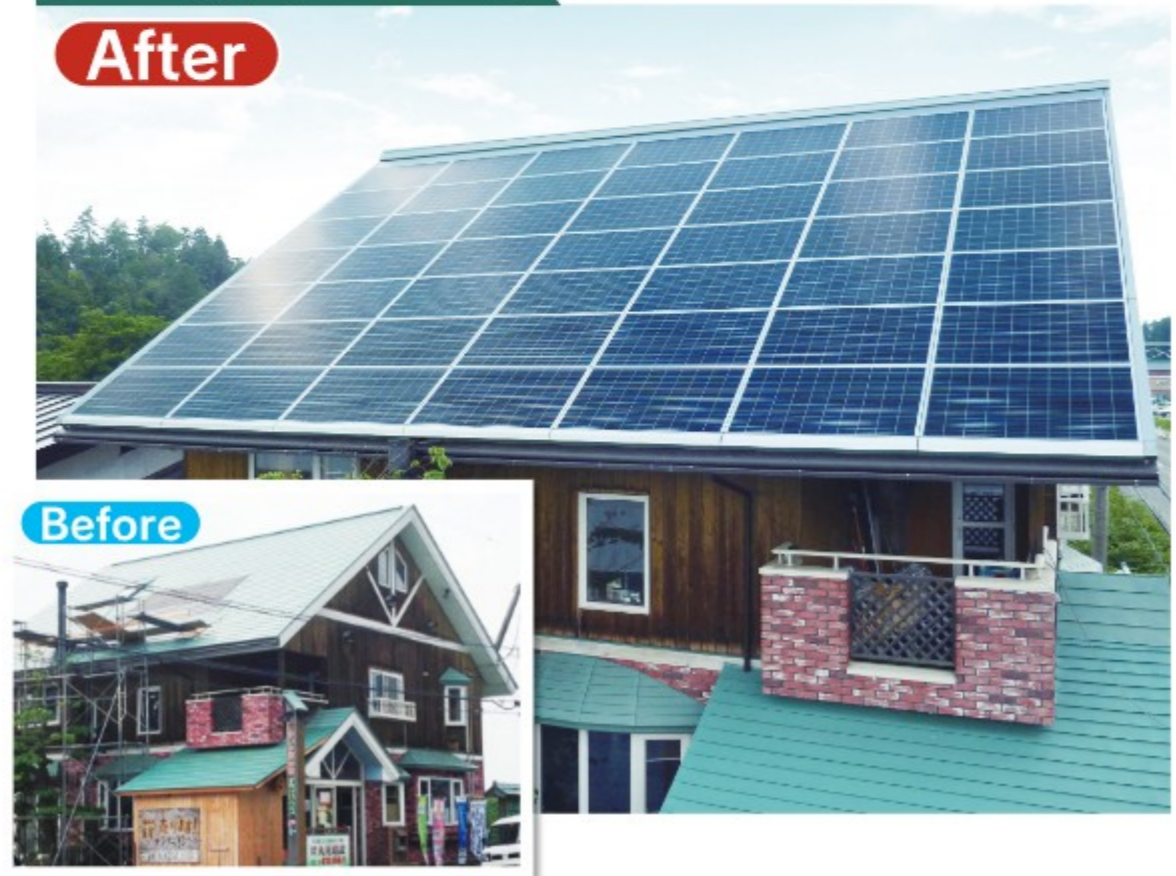
リフォーム 横葺き カバー工法 12.5kW 山形県尾花沢市
