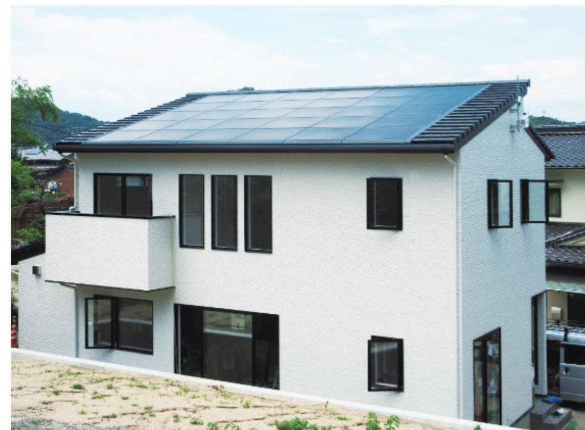
新築 5.1kW 広島県福山市
