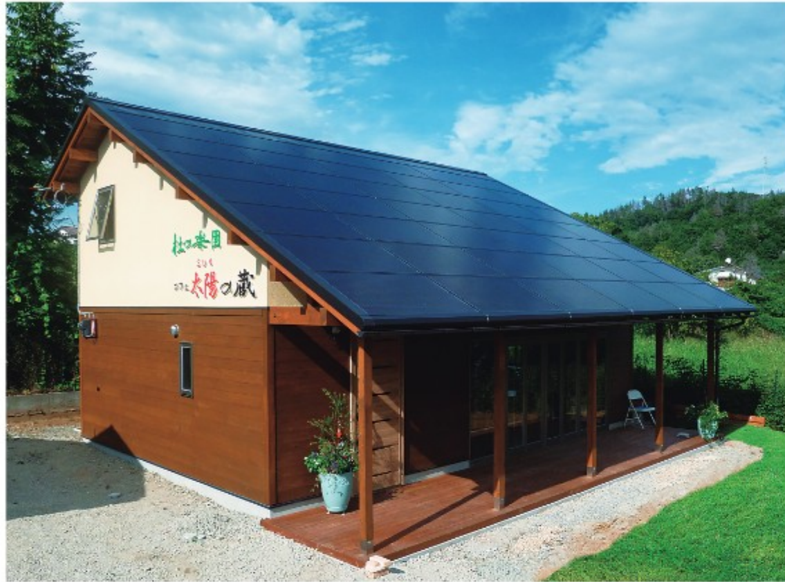
新築 12.18kW 山梨県北杜市
