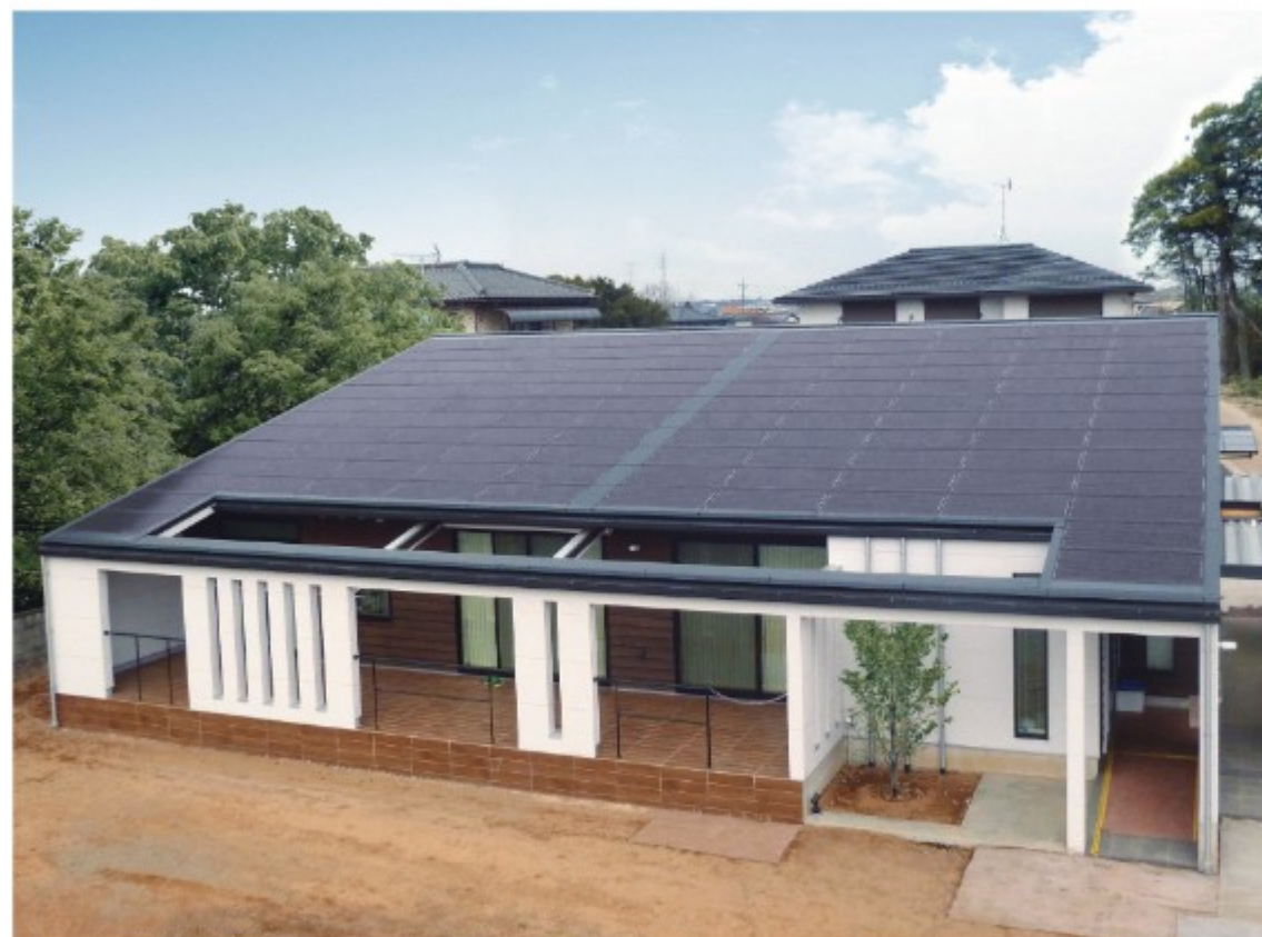
新築 22.23kW 茨城県坂東市
