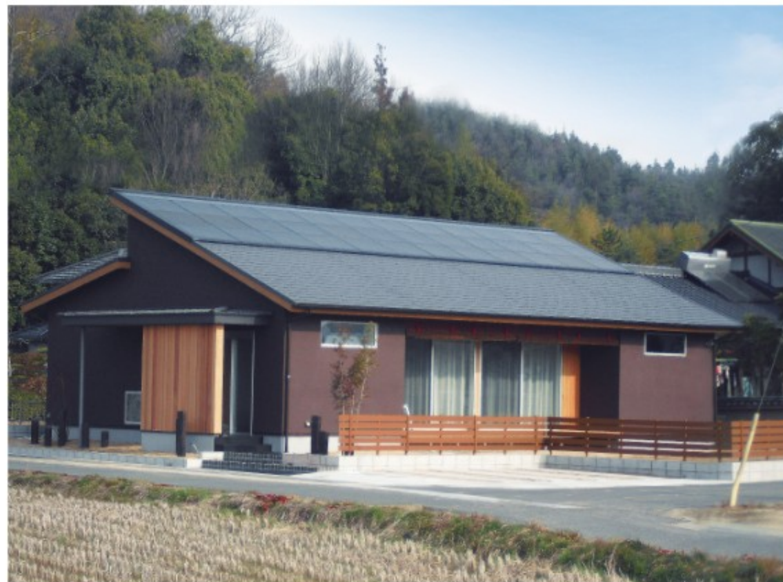
新築 6.12kW 岡山県岡山市
