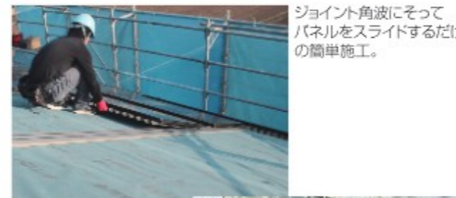
▲パネルの設置
